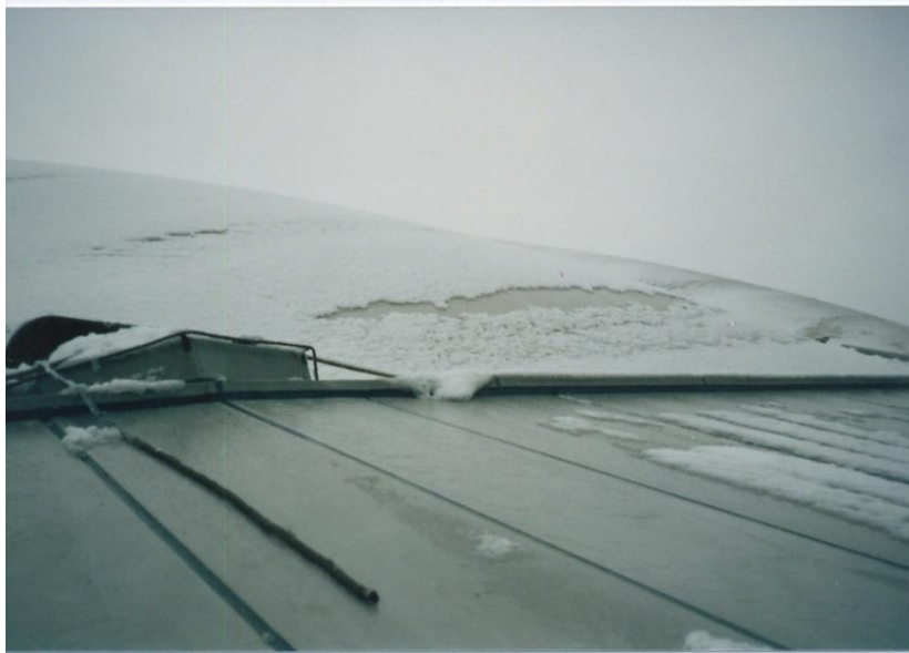
積雪時の屋根外部の状況
