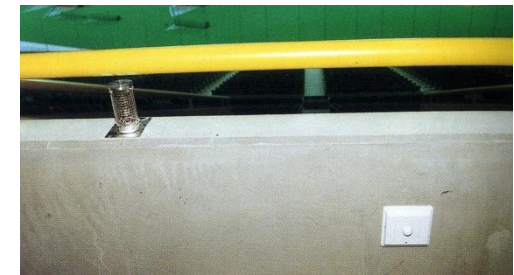
風速センサーと輻射温度計
