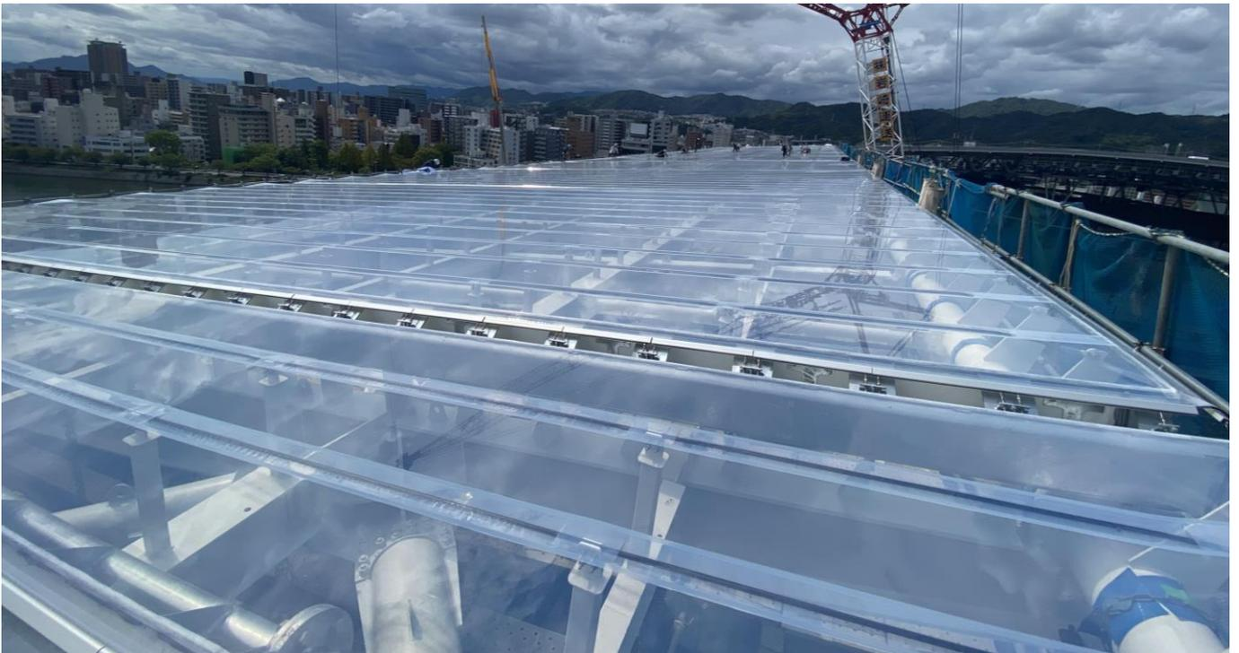
写真7 (a)：現場写真 膜定着完了時
