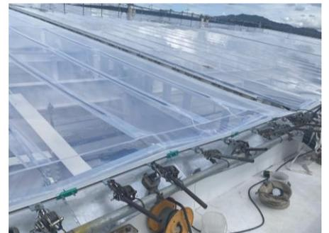
写真7 (d)：膜引込作業状況
