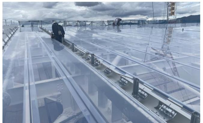
写真4：点検用ワイヤー兼避雷導体の設置
