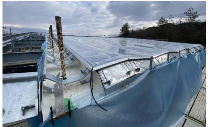
写真6 (b)：モックアップ写真（谷樋部分）
