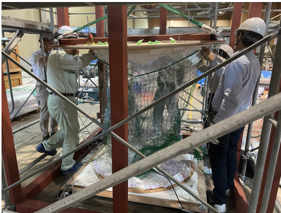
写真5 試験体を組み立てる様子
