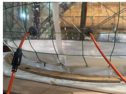
写真9 膜接合部の破断 および 送気口
